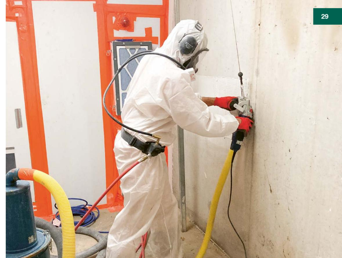
Einsatz der Sanierungsfräse mit Direktabzug und Abstützvorrichtung, Marke Eigenbau.
