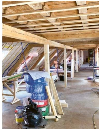
Der Montagebau erfolgte in Holzbauweise mit Dämmungen.
