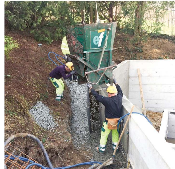
Stützmauern werden zur Flächenvergrößerung um den Pool in die Böschungen gebaut.
