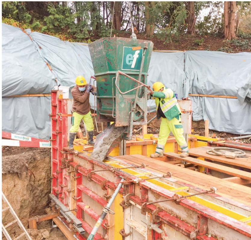
Es wird mit dem Schalungstyp 4-14 betoniert.
