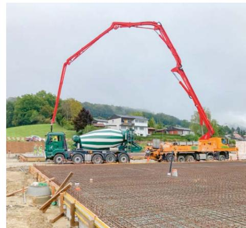
Betoneinbau mittels mobiler Betonpumpe.
