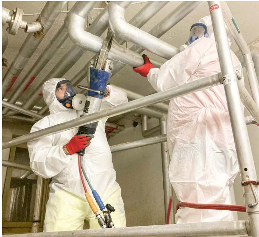
Saniert wurden gut 250m asbesthaltige Rohrisolationen.
