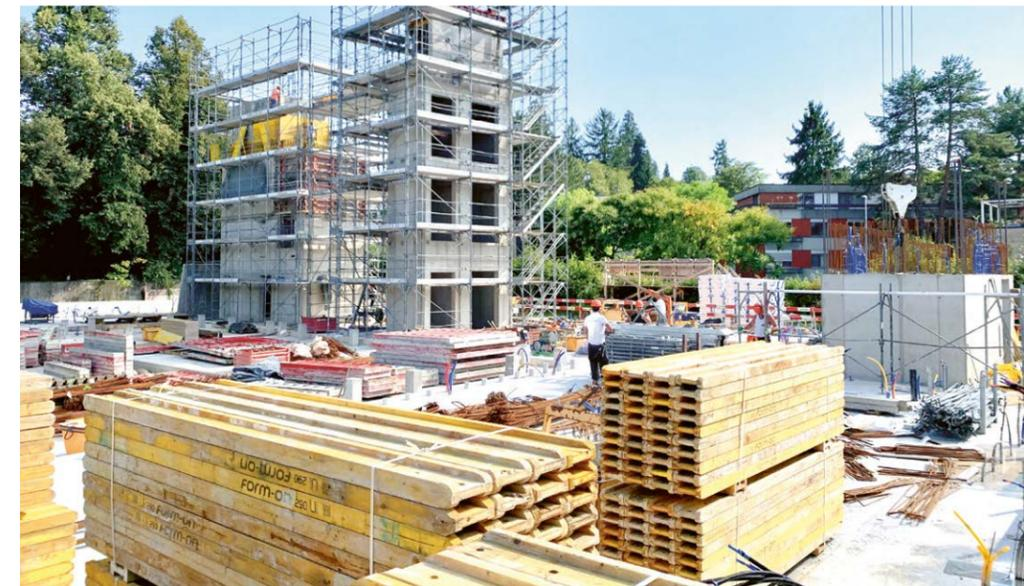
Nur das Untergeschoss sowie die zwei Treppentürme und die Liftschächte werden aus Beton gefertigt.
