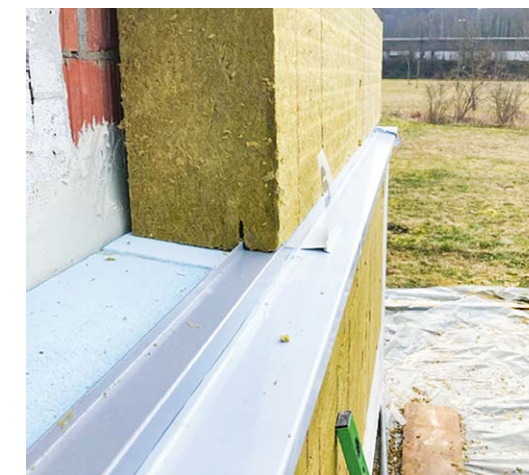
Bei der Montage der neuen Streifbänke wurde darauf geachtet, eine zweite Dichtebene zu erstellen, um zu verhindern, dass später bei Regen Wasser über die Bänke in die Fassade eintritt.
