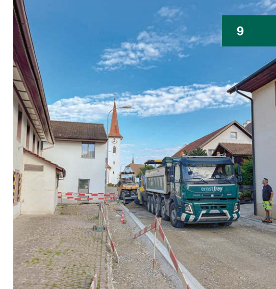
Strassensanierung mit engen Platzverhältnissen und einer Fahrbahnbreite von lediglich 5.50 m.
