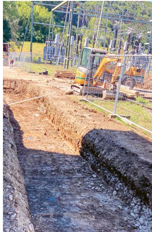
Der Aushub entlang der Starkstromleitungen erfolgte immer unter Aufsicht der Primeo Netz AG.
