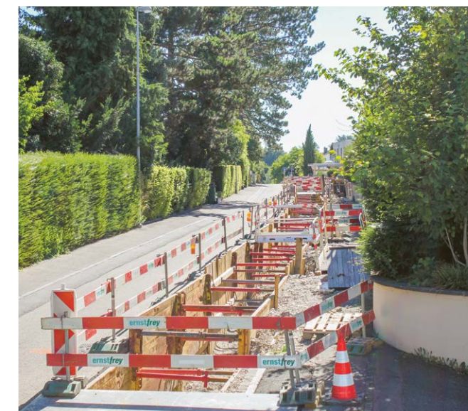
Werkleitungsbau auf einem gut 420m langen Bauabschnitt.
