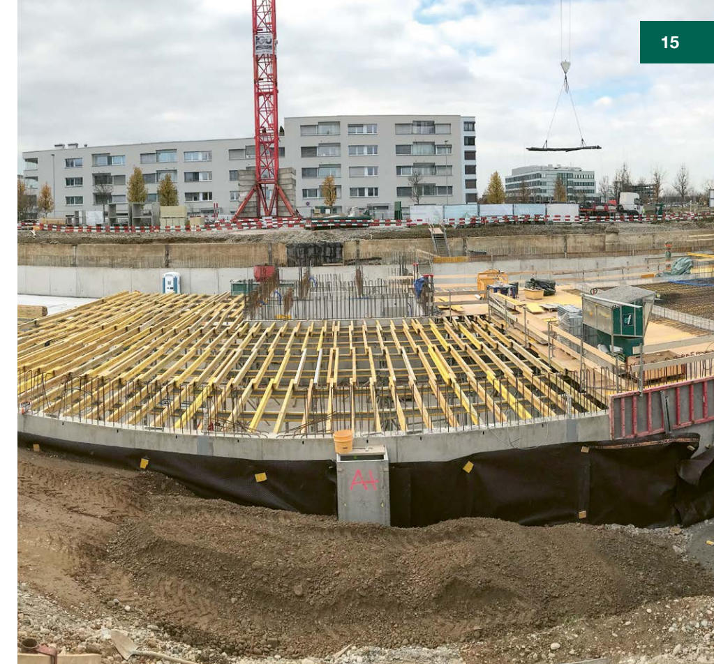
137m lang, 36m breit und 17m hoch soll das Gebäude am Schluss sein.
