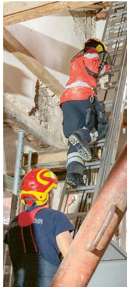
Katzenrettung auf der Baustelle durch die Feuerwehr Arlesheim.
