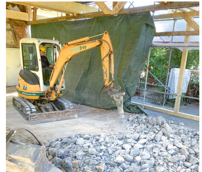
Die Baumeister-Experten führten den Gebäuderückbau sowie den Neubau der Bodenplatte aus.
