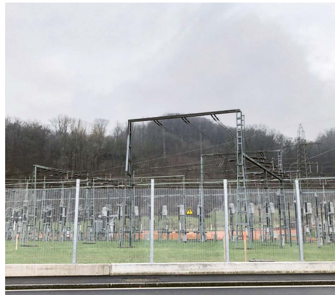
Die ausgeführte Umzäunung des Unterwerks.
