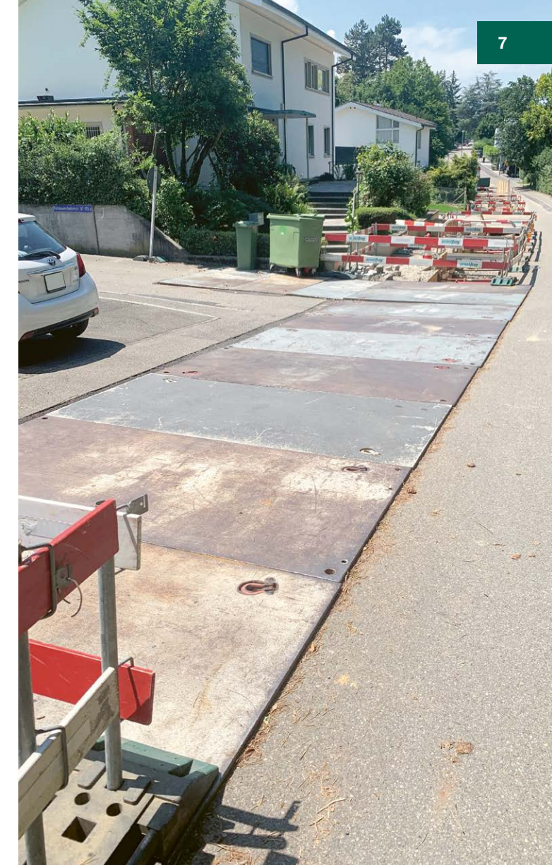
Für die Sicherheit wurden rund 120 Stahlplatten und gut 30 Fussgängerbrücken in den Zufahrten versetzt.
