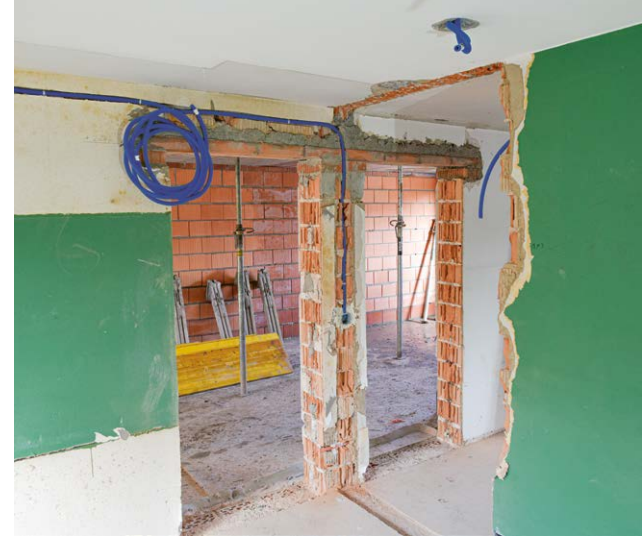
Die besondere Herausforderung bei einem Anbau besteht darin, die Höhen vom bestehenden Gebäude und dem neu anzubauenden Teil aufeinander abzustimmen.
