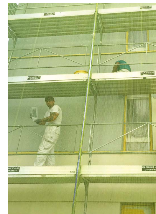
Die Fassade wurde zum Abschluss mit Silikonharzputz abgerieben und gestrichen.
