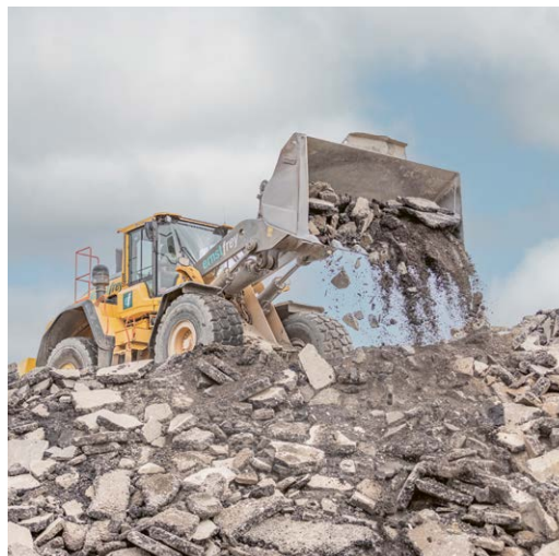
Abbruchmaterial wird für die Wiederverwertung vor Ort aufbereitet.
