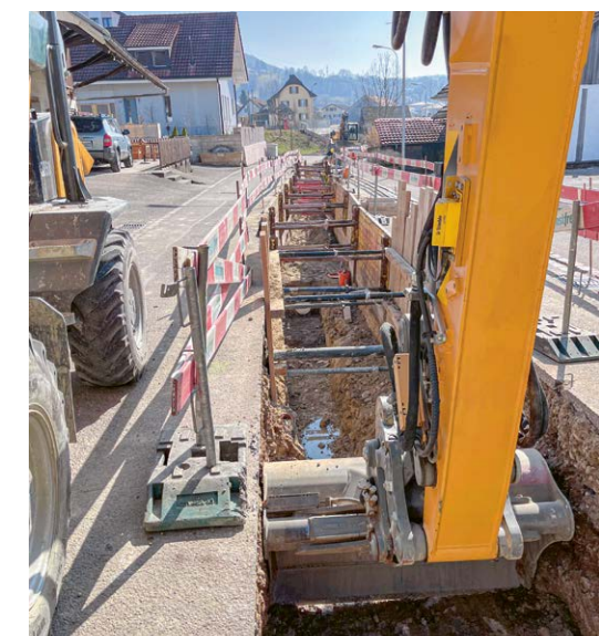
Die projektierte Leitung liegt mittig in der Strasse, was zu einer vorübergehenden Strassensperrung führte.
