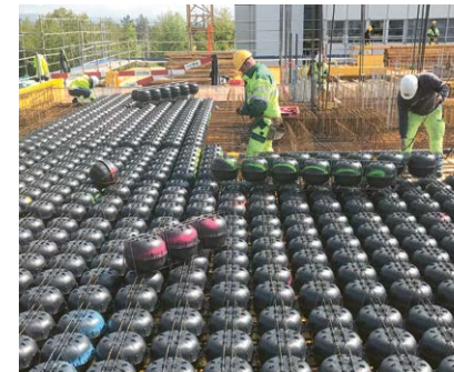
Mit dem Einsatz von Cobiax-Elementen wurde eine Hohlkörperdecke erstellt.
