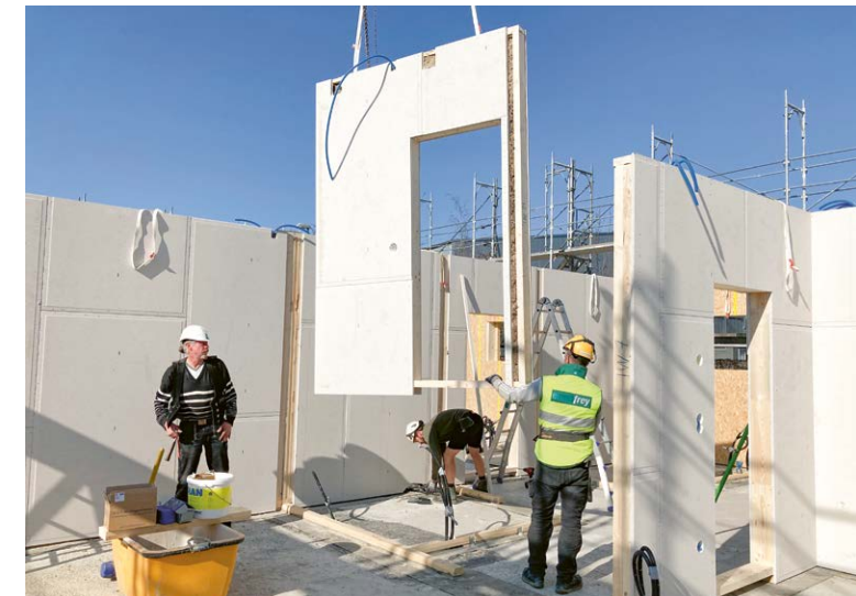
Die Wände und Dachelemente wurden auf dem eigenen Werkhof wetterunabhängig produziert.
