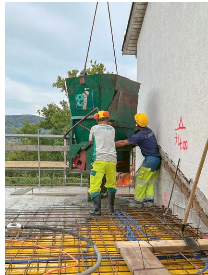
Die Decke des Erdgeschosses für den Anbau wird betoniert.
