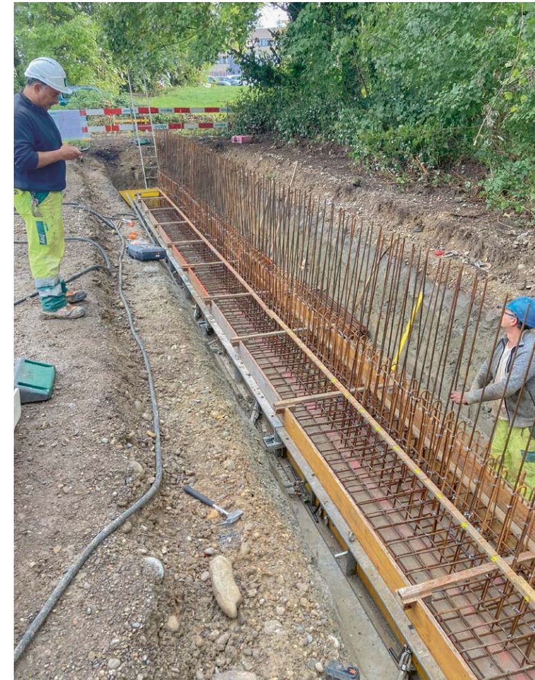
Nach dem Aushub erfolgte der Bau der Stützmauer.
