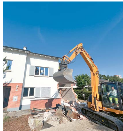
Abbruch der bestehenden Garage, um so Platz für den geplanten Anbau zu schaffen.
