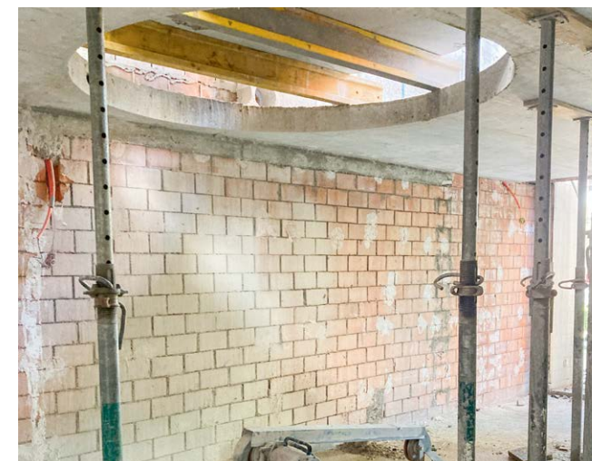
Aufwändige provisorische Unterspriessungen und Unterfangungen wurden eingebaut, die im Anschluss eine offene Wohnraumeinteilung ermöglichten.
