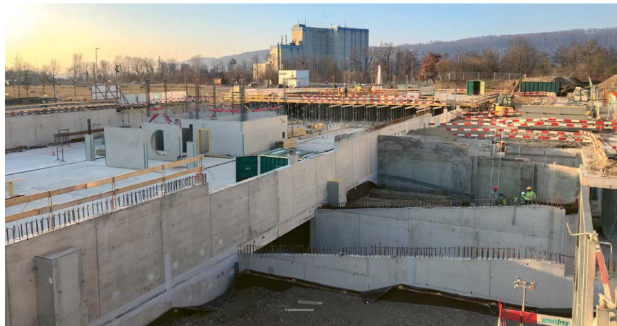
Der ganze Rohbau wurde als Stahlbeton-Skelettbau konzipiert.
