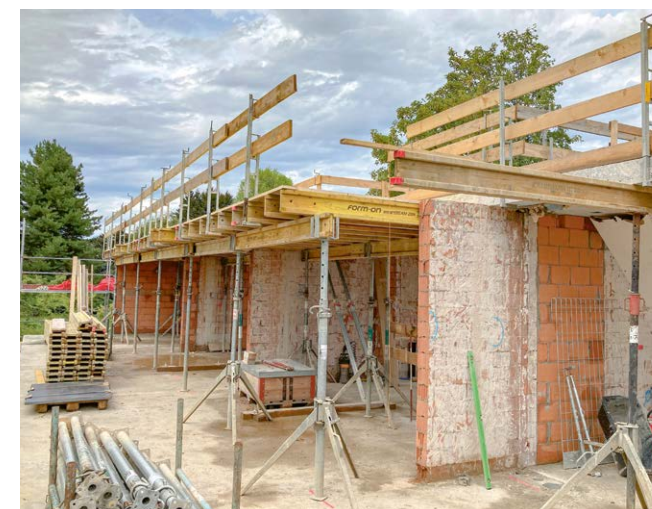
Die alte Backsteinfassade wurde entfernt und später durch grossflächige Fassadenfenster ersetzt.
