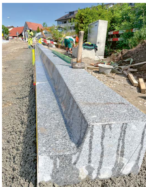
Sämtliche Randabschlüsse wurden aus eigener Hand erstellt.
