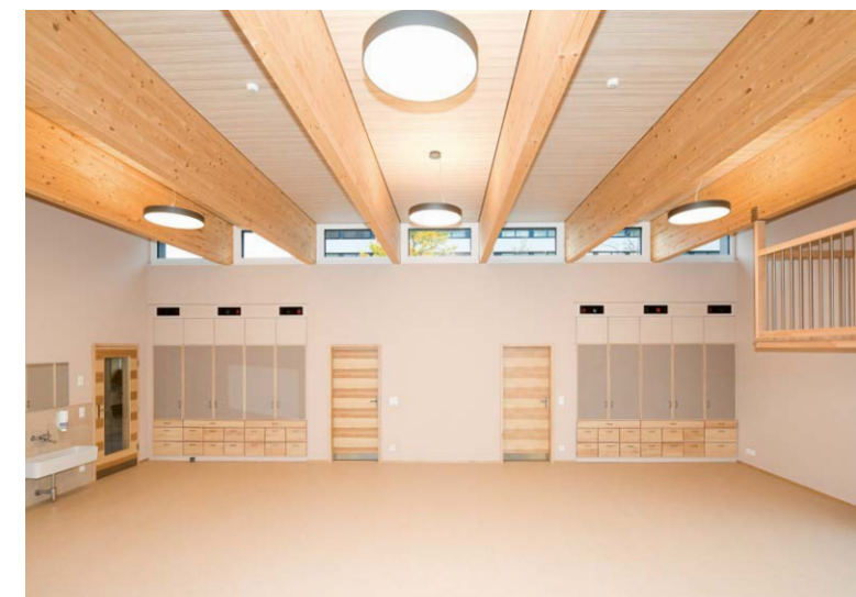
Im Innenausbau wurde Eschenholz für die Wand- und Bodenbeläge sowie für die Akustikdecke ausgewählt.
