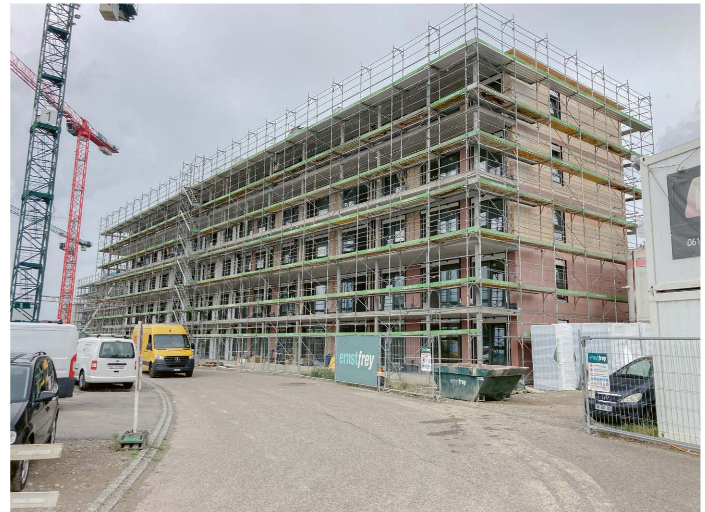
Von März bis September 2023 wurde die verputzte Fassadendämmung ausgeführt.
