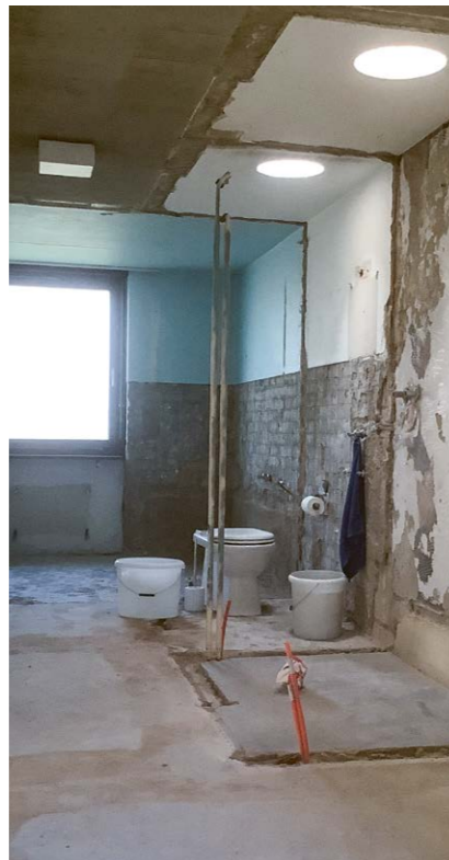
Das Badezimmer im OG wird erweitert und mit einer begehbaren Dusche und einer frei stehenden Badewanne ausgestattet.
