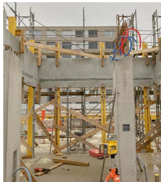
Ab den Obergeschossen gehört zu jeder Wohnung ein Ortbetonbalkon, der umseitig mit vorfabrizierten Betonelementen umschlossen ist.
