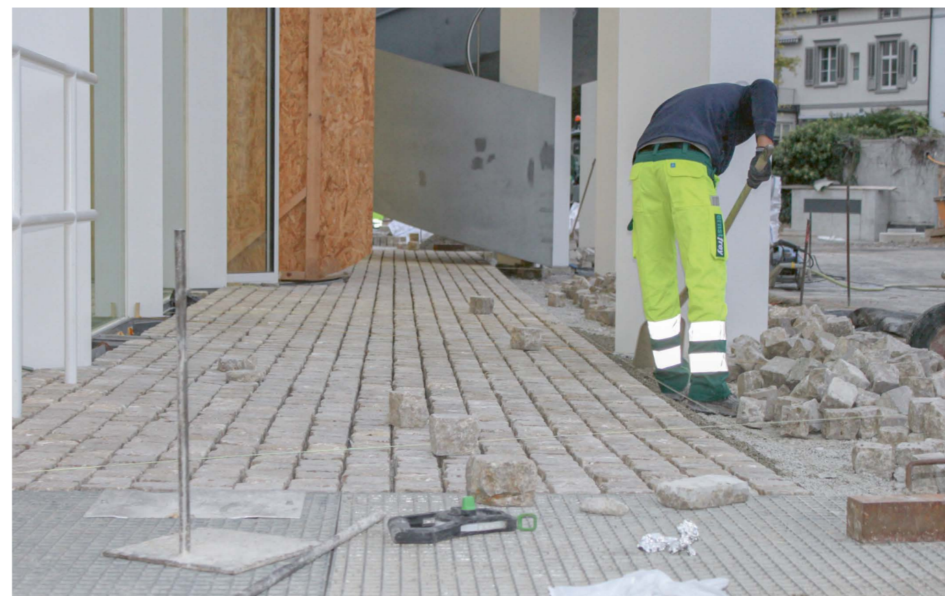
Der Wachenzeller Dolomit gilt als besonders frost- und tausalzbeständig.
