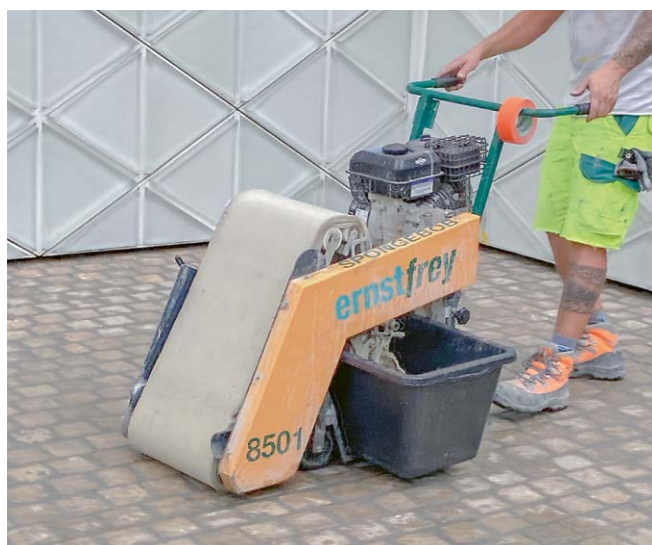
Eine Pflasterung ist reine Handarbeit, es gibt keine speziellen Maschinen dafür.
