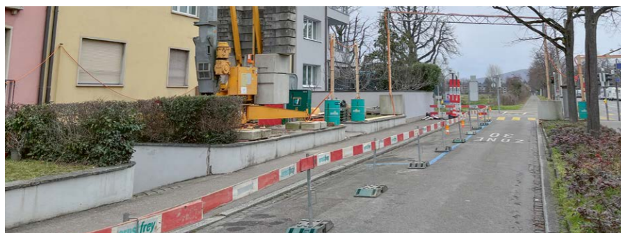
Nach über 80 Jahren war es an der Zeit, die Liegenschaften zu modernisieren und energetisch aufzuwerten.
