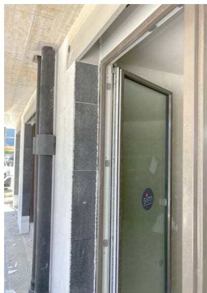
Hohlsturzelement unter Balkonplatte, Fensteranschluss mit Dichtband.
