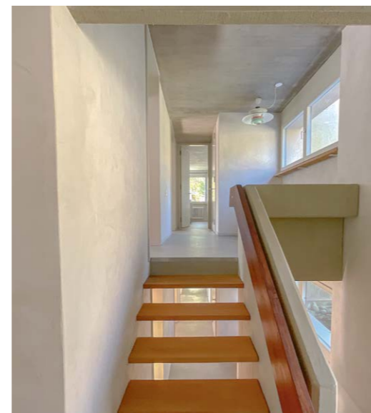
Der zement- und gipshaltige Grund- und Deckputz wurde abgetragen und durch mineralischen Kalkputz ersetzt, zu einer nachhaltigen Verbesserung des Raumklimas.
