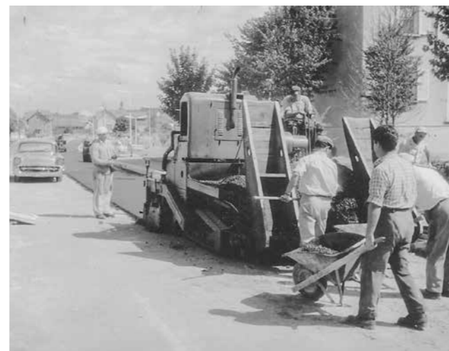
Belagseinbau anno dazumal
