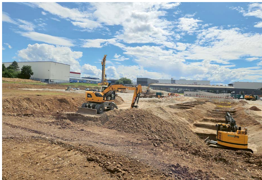
Der Untergrund musste mittels Betonfundamenten und einer Koffering realisiert werden, um die Tragfähigkeit zu gewährleisten.
