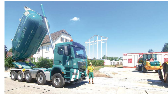
Hervé mit dem 5-Achs-Silowagen beim Belagseinbau.
