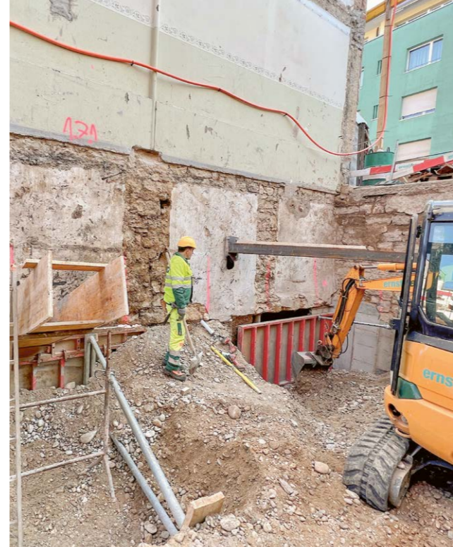
Betonunterfangungen der Nachbargebäude waren nötig, weil das neue Untergeschoss tiefer liegt als die Nachbarkeller.
