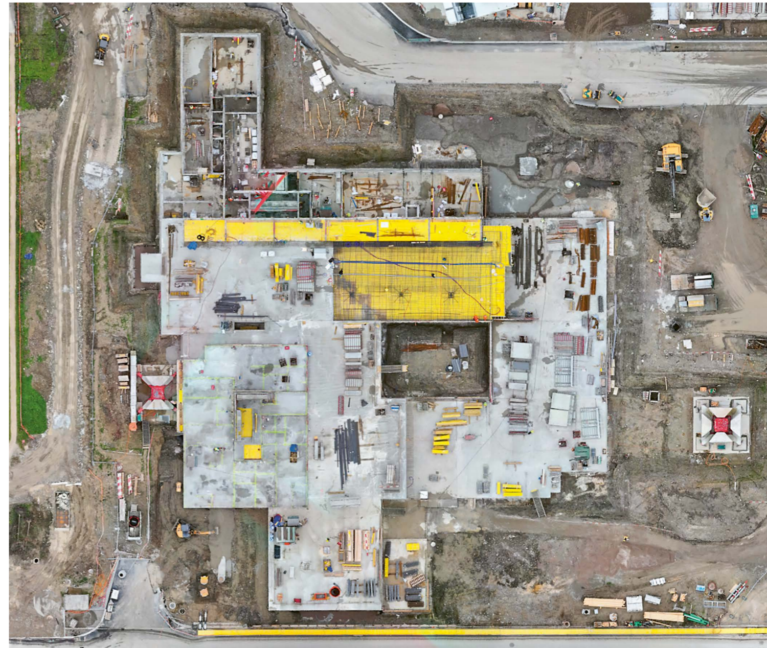
Baustellenübersicht Römerpark II aus der Vogelperspektive, Dezember 2022.
