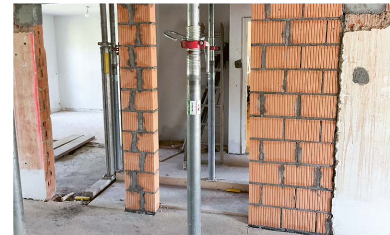
Neue Auflager für die spätere Tragkonstruktion wurden betoniert und Wände aufgemauert.
