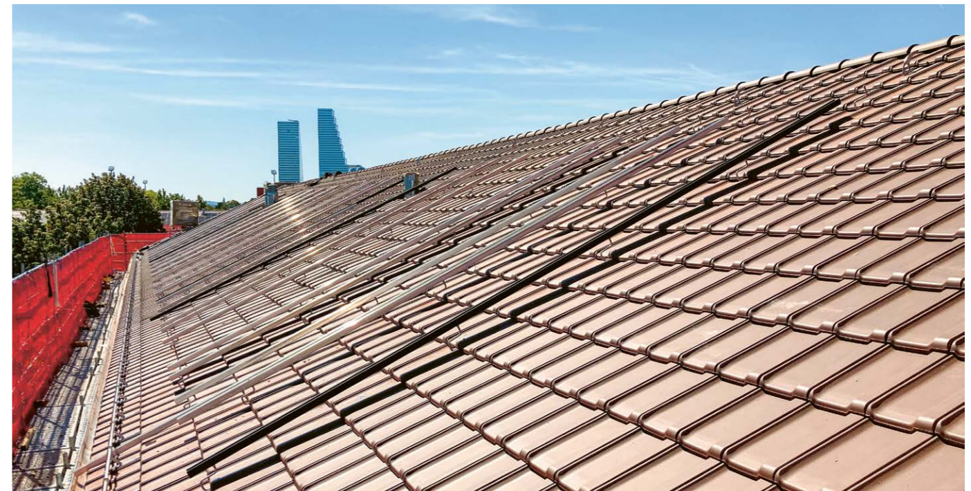
Auf dem sanierten Dach wurden Grossflächenziegel als Wetterschutz verlegt.
