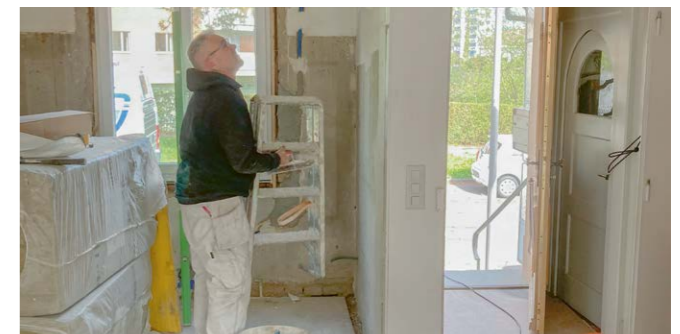
Neben Deckenspots und Lampenstellen wurde die Trittschalldämmung des Obergeschosses verbessert.
