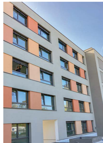
Die fertiggestellte Fassade mit einer modernen bunten Farbgestaltung der zurückgesetzten Fassadenfelder.
