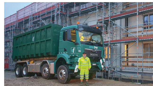
Frühmorgens im Einsatz – Niki beim Container-Stellen auf der Baustelle unterstützt durch neues 4-Achs-Hakengerät.
