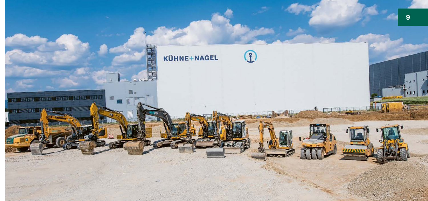
Für die Abtragungsarbeiten des Oberbodens (ca. 7000m 3 ) und den Aushub (ca. 50 000m 3 ) brauchte es viele Maschinen.
