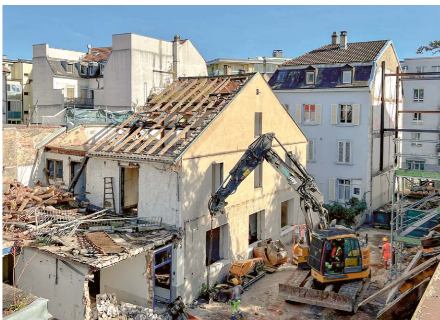
Abbruch der Hinterhofgebäude.
