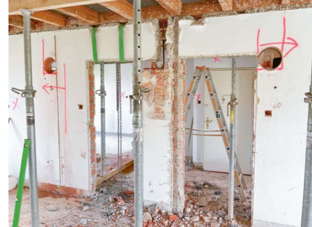
Böden, Decken und teilweise auch Wände wurden in Handarbeit abgebrochen.
