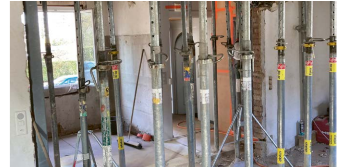
«Alles muss raus» – so gut wie alle Innenwände des Erdgeschosses wurden abgebrochen.
