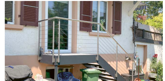
Durchbruch in der Aussenwand für einen Zugang zum Garten.
