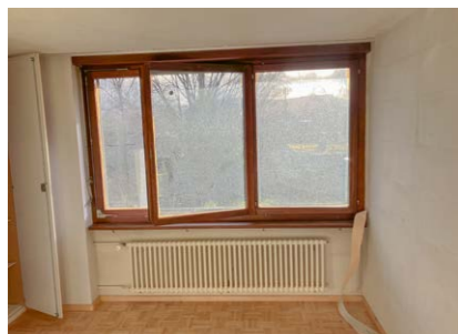
Eine aufwändige und detailreiche Aufgabe war der Ersatz der alten, originalen Fenster und Türen.
