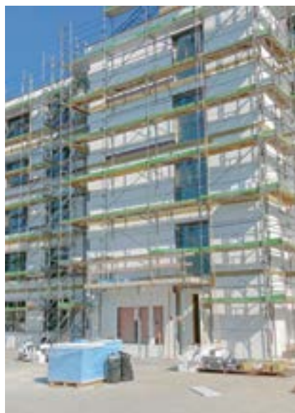
Ein grosser Teil der Fassadendämmung auf der Nordseite des Projektes wurde mit 6cm zurückversetzten Fassadenfeldern stockwerkweise ausgebildet.
