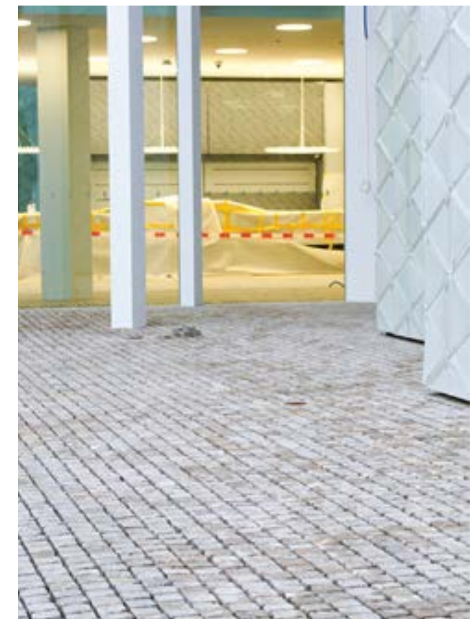
Rund 1350m 2 Pflasterung wurden eingebaut.
