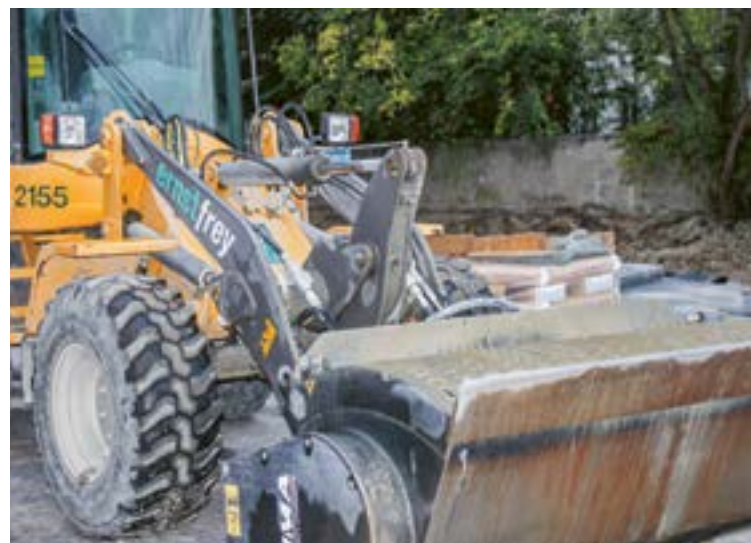
Der Radlader mit Betonmischschaufel mischt Splitt- und Sickerbeton zum Versetzen der Steine.
