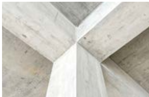
Als Abschluss des jeweiligen Stockwerks wurden die Sichtbetondecken auf die Sichtbetonstützen und Unterzüge geschalt und betoniert.
