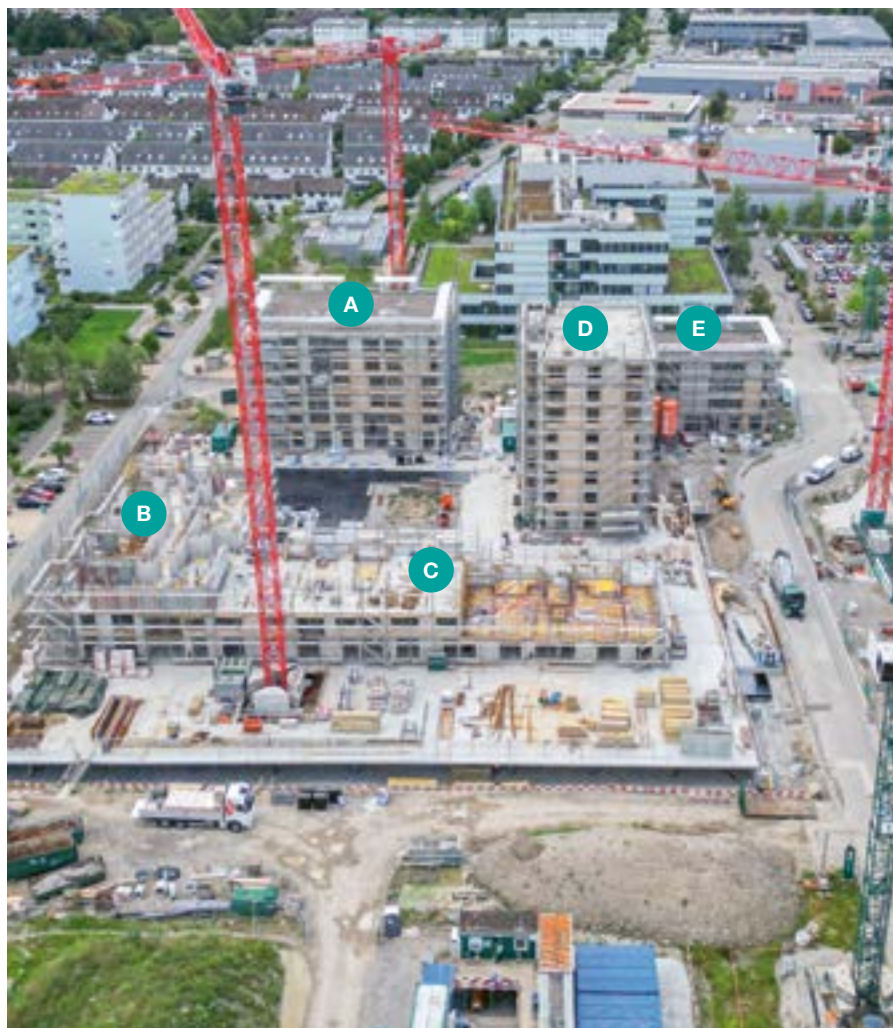
Baustellenübersicht Römerpark II, August 2023.
