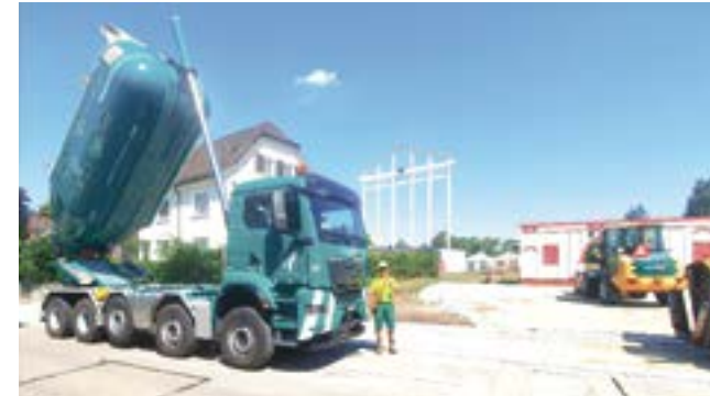
Hervé mit dem 5-Achs-Silowagen beim Belagseinbau.
