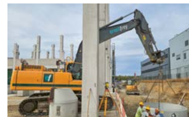
Eine Herausforderung war die Umlegung der Hauptkanalisation von gut 80 m Länge der Gemeinde Möhlin.
