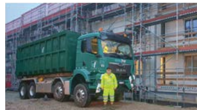
Frühmorgens im Einsatz – Niki beim Container-Stellen auf der Baustelle unterstützt durch neues 4-Achs-Hakengerät.
