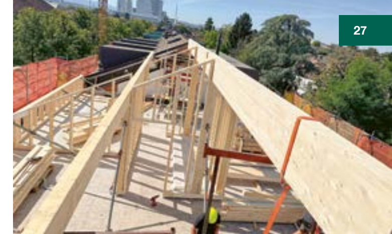
Die Innenwände zum Treppenhaus sowie die Wohnungstrennwände wurden vorgängig in der Werkhalle produziert und als Elemente angeliefert.
