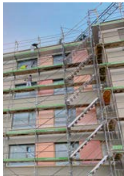
Endspurt mit dem Anstrich auf der fertiggestellten Fassade der Nordseite von Haus 15 und 17 im Oktober 2023.
