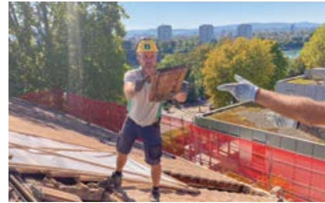
Die alten Dachmaterialien wurden bis auf die tragende Dachkonstruktion zurückgebaut.
