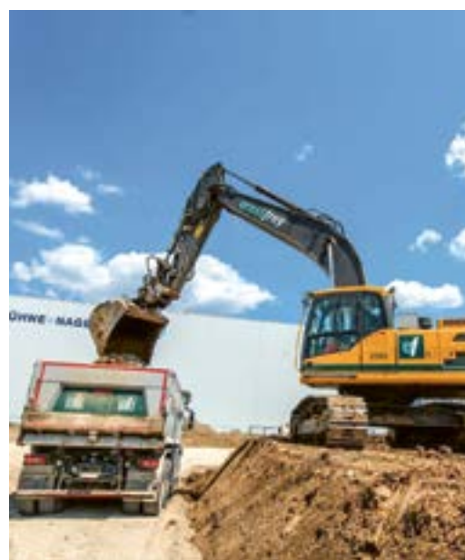
Aufgrund des sportlichen Terminprogramms musste der Abtrag in kürzester Zeit und höchst effizient von unseren Maschinisten vollzogen werden.
