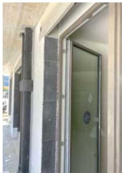
Hohlsturzelement unter Balkonplatte, Fensteranschluss mit Dichtband.
