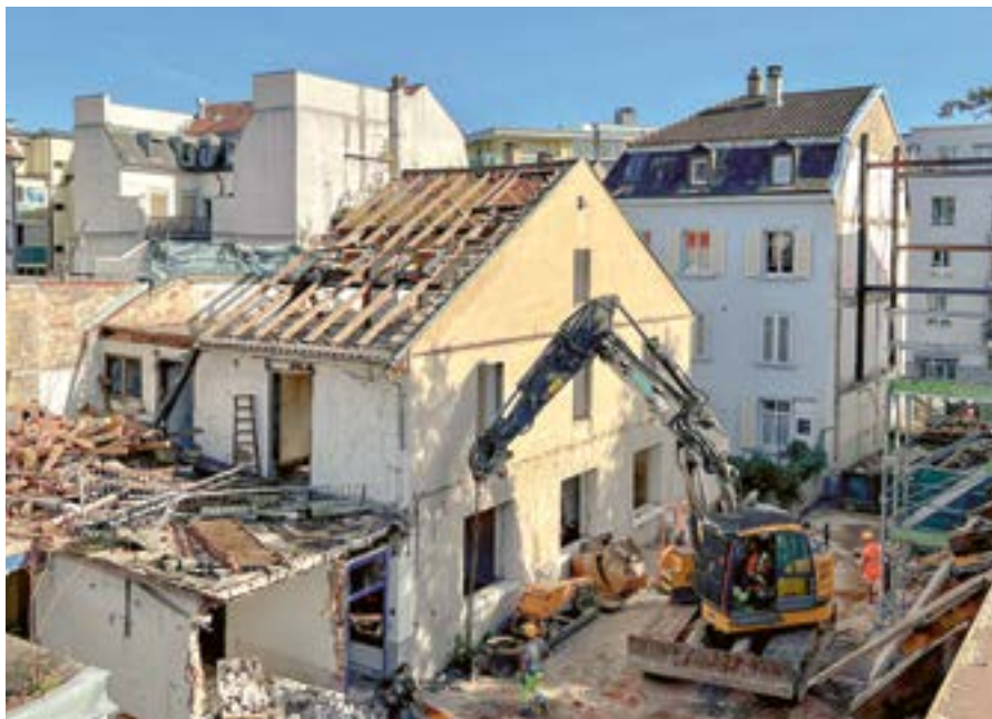
Abbruch der Hinterhofgebäude.
