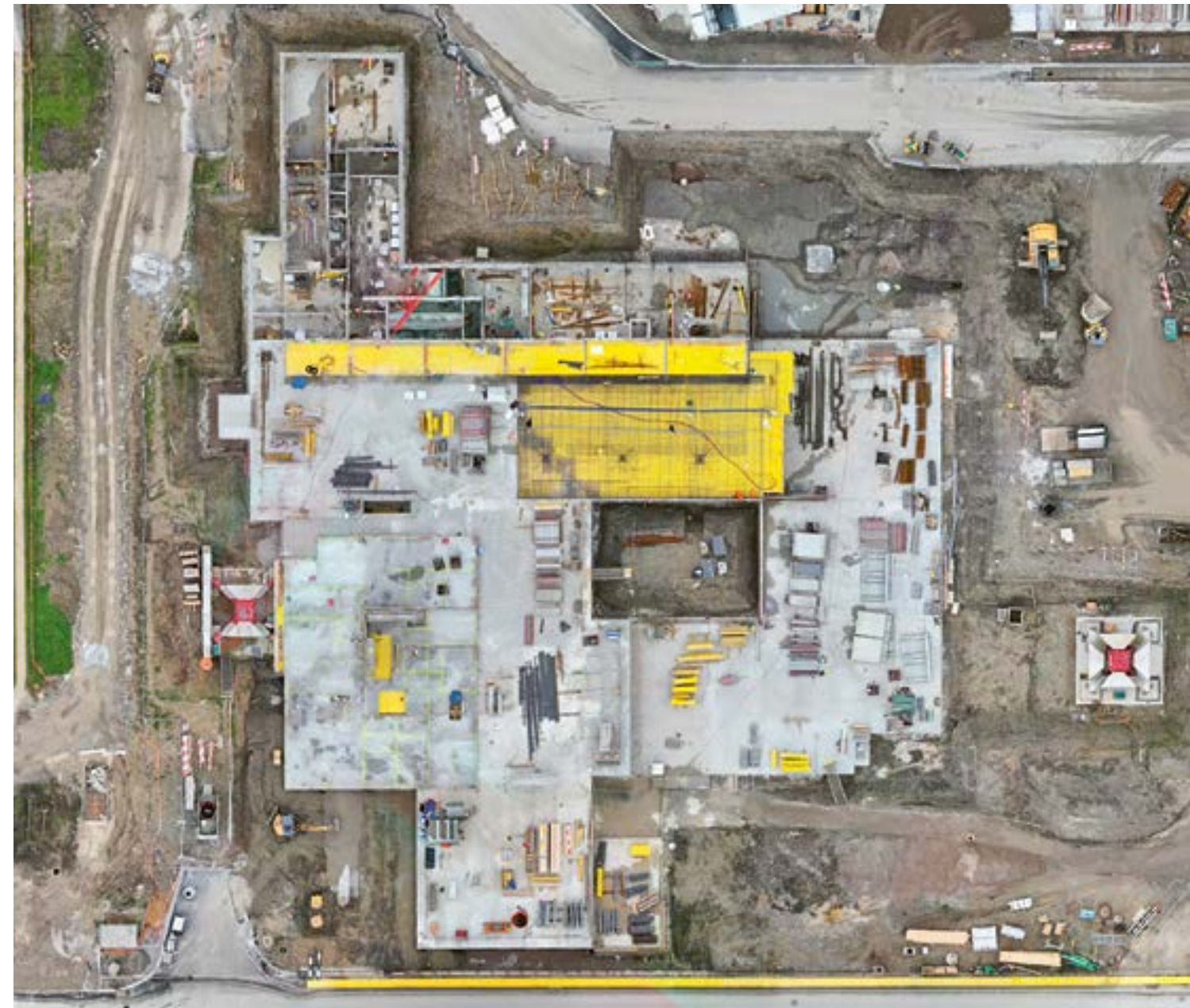
Baustellenübersicht Römerpark II aus der Vogelperspektive, Dezember 2022.
