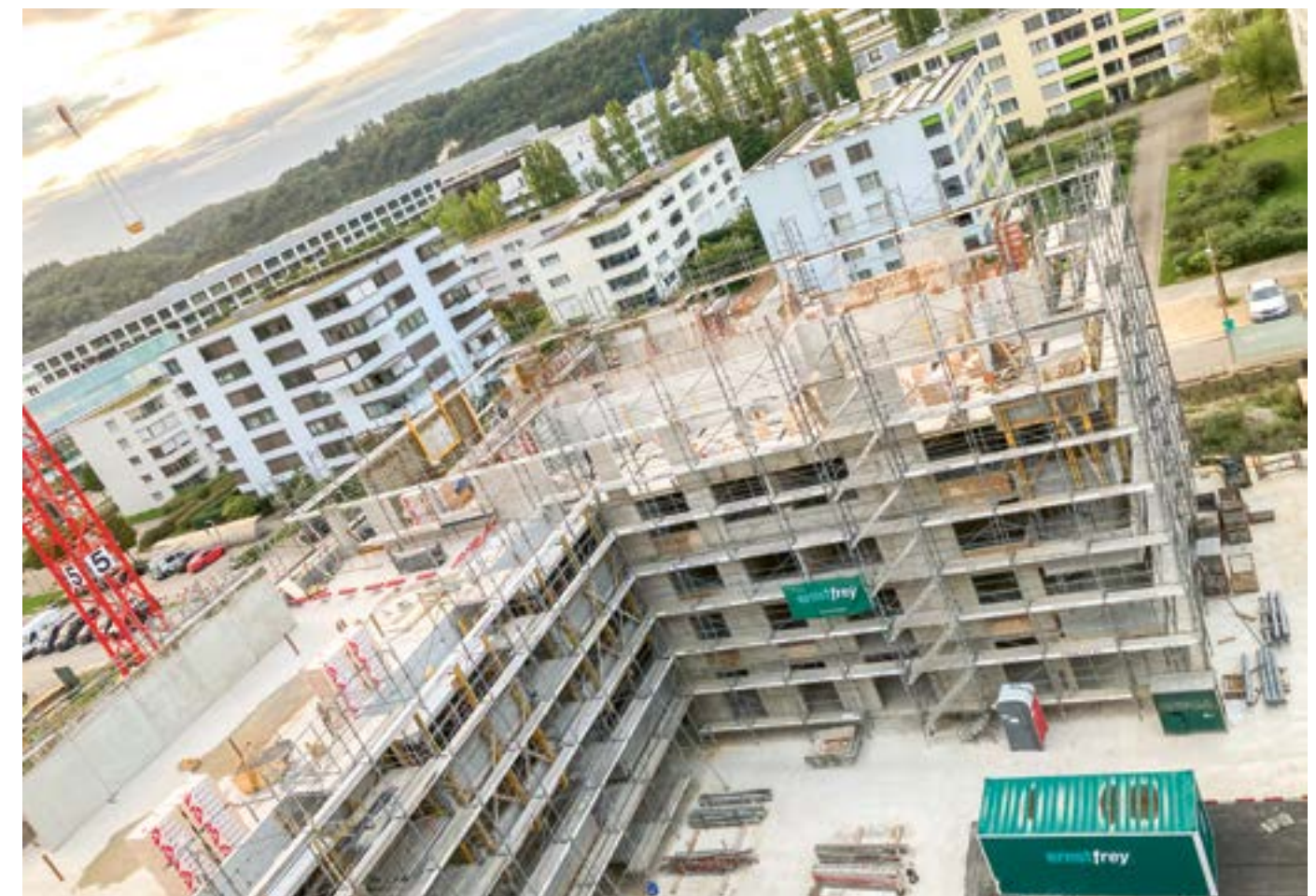
Das Eigenprojekt – die grösste Baustelle im Portfolio unserer Firma.
