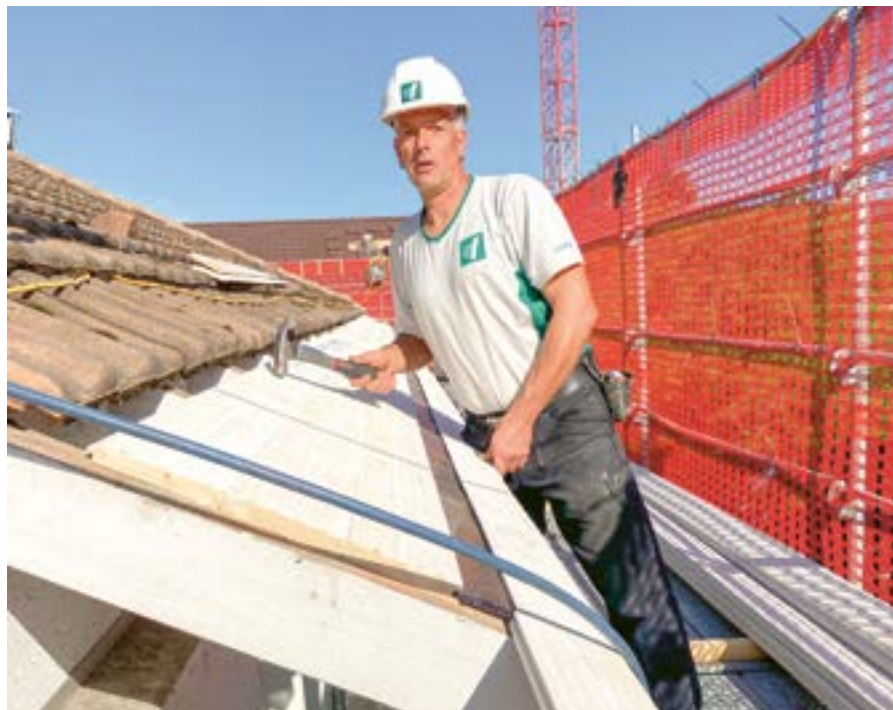
Gleich zum Baustart im September 2022 konnten wir unseren neuen, erfahrenen Holzbau-Polier Jörg Noserke einsetzen.
