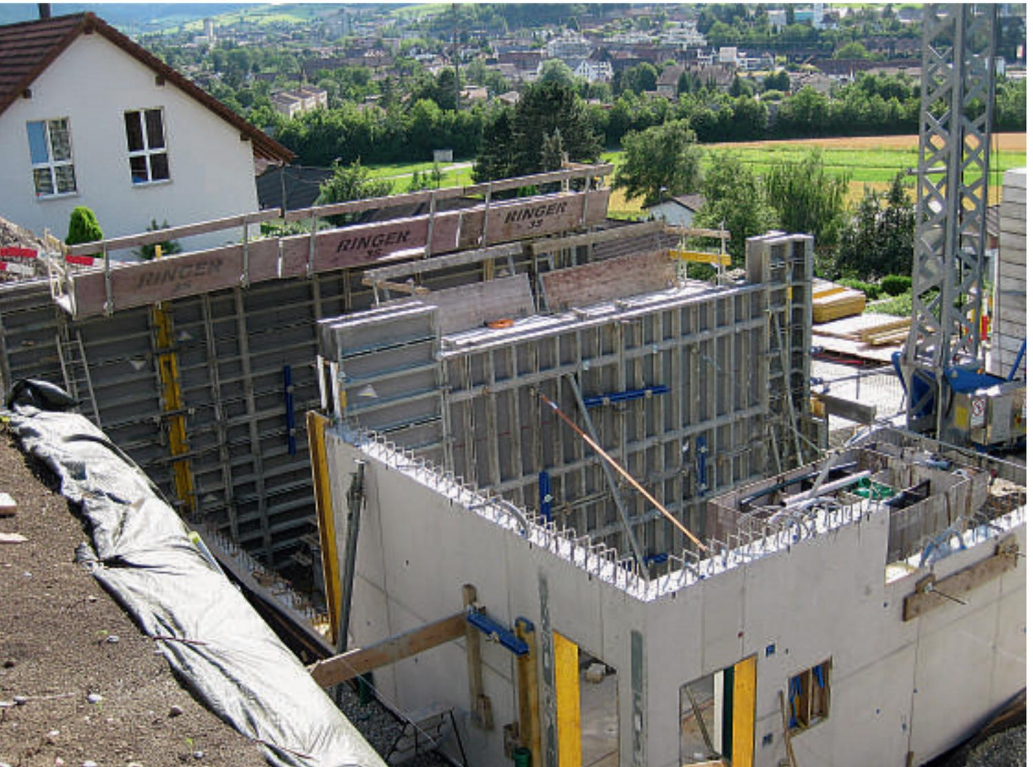
Am Frickberg, an steilster Hanglage, durften wir ein Terrassen-Einfamilienhaus erstellen. Als die Kollegen vom Tiefbau mit dem Aushub fertig waren, konnten wir vom Hochbau den Kran montieren und die Baustelle installieren. Schon zu Beginn gab es die eine oder andere Knacknuss. So musste zum Beispiel die Böschung mit über neun Meter Höhe gesichert werden. Da waren gute Ideen von allen Involvierten gefragt. Nach intensiver Beratung mit
