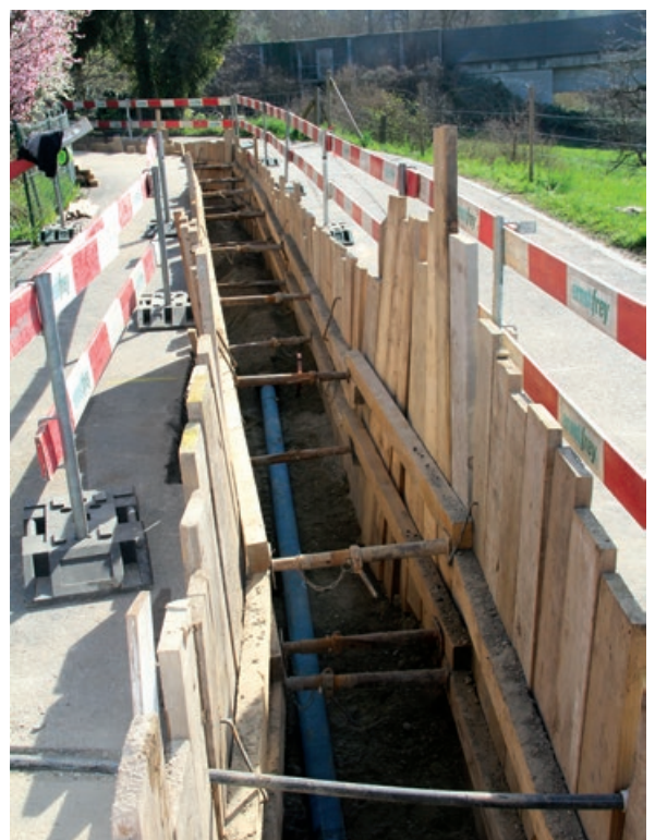
Grabenspriessung, Signalisation und Absperrung
