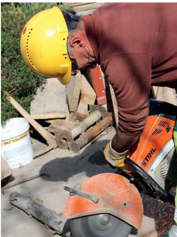
Tragen der persönlichen Schutzausrüstung
