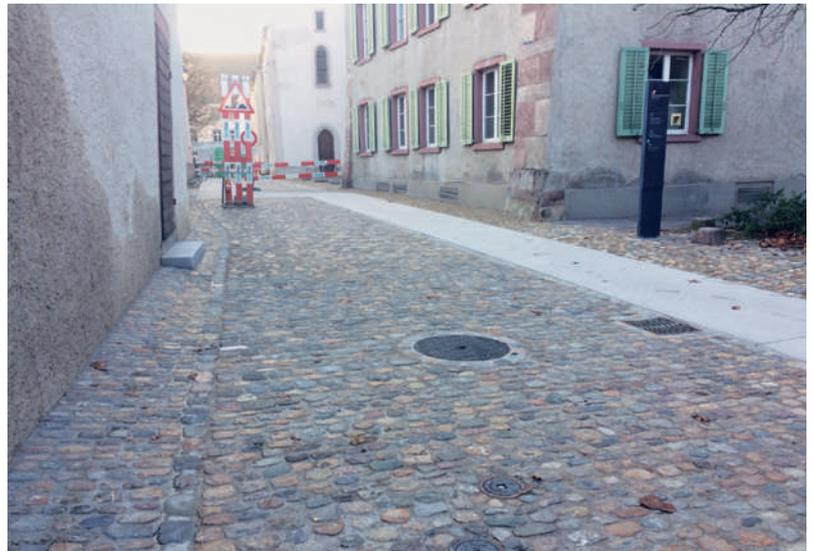
Nach Fertigstellung der Betonarbeiten wird dann im Frühjahr 2018 mit dem sogenannten «Kleweg-Verfahren», welches die Oberflächenstruktur aufraut und die Steinstruktur im Beton hervorhebt, die Betonoberfläche abgeschliffen. Somit fügt sich die neue Betonplatte sehr schön in das neue Strassenbild und ergänzt optisch die Natursteinpflasterung. Ein zusätzlicher Vorteil ist die ebene Fläche, die vor allem gehbehinderten Menschen entgegenkommt.
