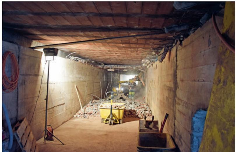
Einsatz mit Bravour. Ab dann ging es Schlag auf Schlag. Takt um Takt wurde gebohrt, eingeklebt, armiert, geschalt und betoniert. Nach 8 Abschnitten war das Werk im vorgegebenen Zeitrahmen vollbracht. Nach Ausbau der Schalung und Demontage des Gerüsts konnte der Stahlbauer mit dem Einbringen und der Montage der Abgasrohre beginnen, um rechtzeitig zum Jahresende die Inbetriebnahme der ersten Anlagen zu ermöglichen.
