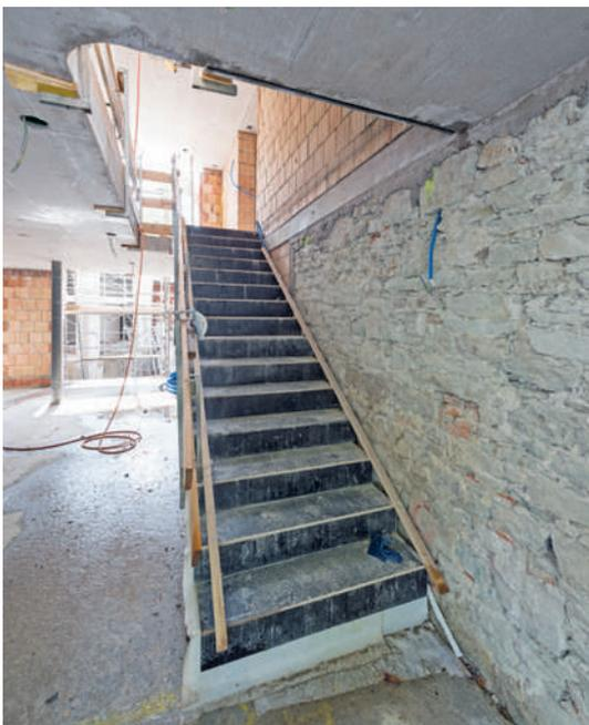
An den Grundmauern angekommen, war es an der Zeit, das Gebäude wieder aufzubauen und die verbleibenden Fassaden in die neue Bausubstanz zu integrieren. Die neue Fassade wurde aus einem Unipor-Mauerwerk erstellt. Sämtliche Geschossdecken, rund 400 m<sup>2</sup>, sind in Schalungstyp 4.1.4 erstellt. Im Altbau wurden ca. 400 m<sup>2</sup> Mauerwerk ausgeführt sowie 450 m<sup>2</sup> Betonwände geschalt.
