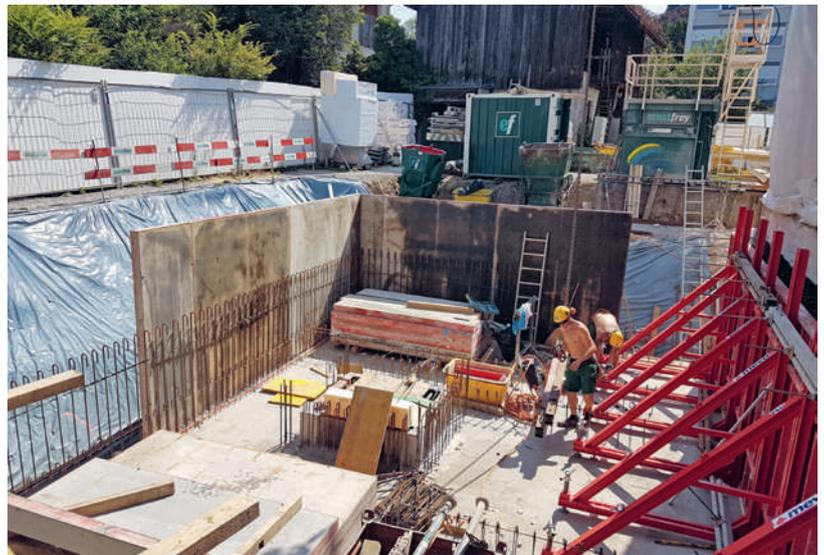
Nach dem Erstellen des Untergeschosses haben wir mit den Sichtbetonarbeiten im EG angefangen. Der Liftschacht sowie die Betonwände im Wohnbereich und in der Galerie wurden mit Ammocret-Beton betoniert und später gestockt.
