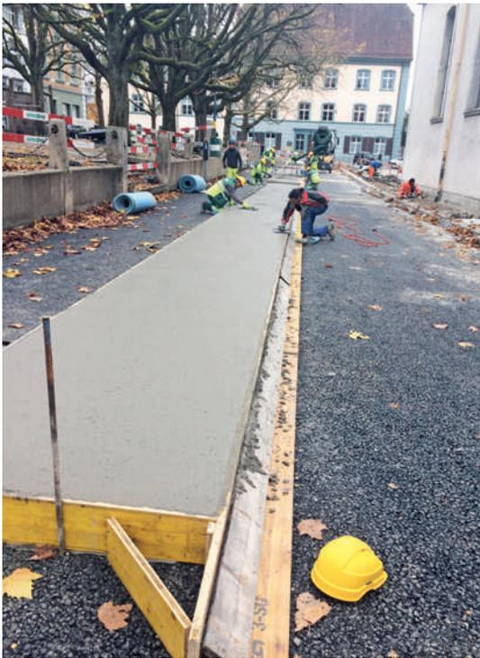
schieden. Die Betonplatte wurde auf den zuvor eingebauten Drain-Asphalt errichtet, der als sickerfähiger Belag den Oberbau verstärkt.
