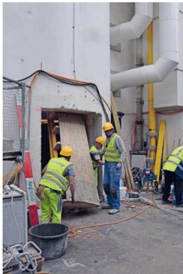
Im Januar, bei frostigen Temperaturen ausserhalb und bis 45 Grad auf der Baustelle innerhalb des Gebäudes, startete die Mannschaft von Harald Englert mit den Vorbereitungsarbeiten für den Abbruch von Wänden und Decken des unter dem Dach liegenden Rauchgaskanals. Der Boden dieses Tunnels musste mit Beton- und Stahlträgern verstärkt werden, da die tragenden Wände zum Teil abgebrochen wurden, um für die neuen Abgasrohre aus Stahl Platz zu schaffen.
