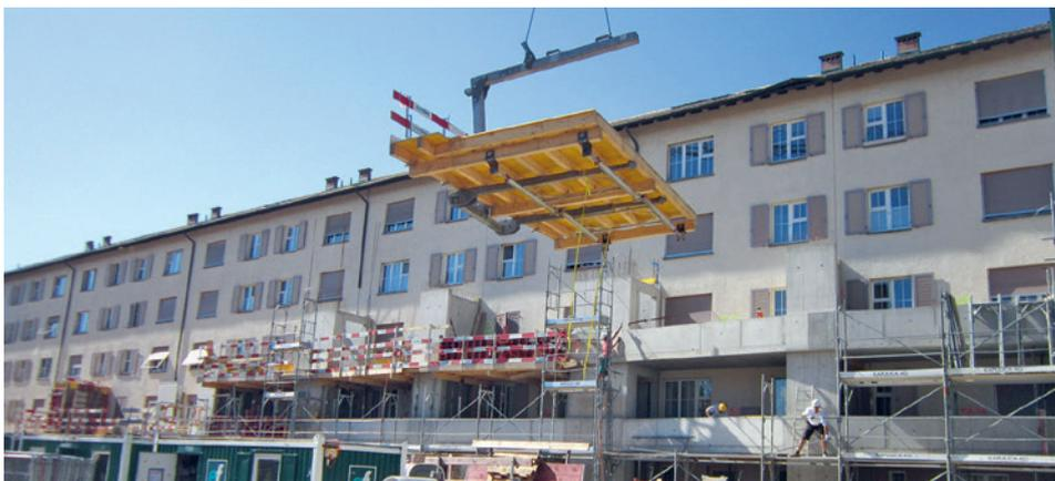
Spezialkonstruktion zur Unterstützung der Schalarbeiten an Balkonen und Liftschächten
