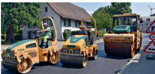
Walzentrio verdichtet den eingebauten Belag
