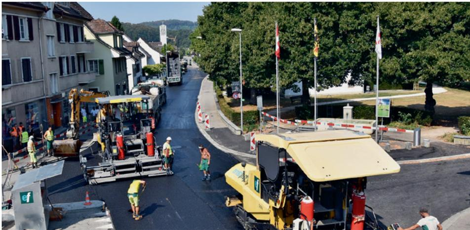
Einbau von lärmreduzierendem Belag an der Hauptstrasse in Pratteln
