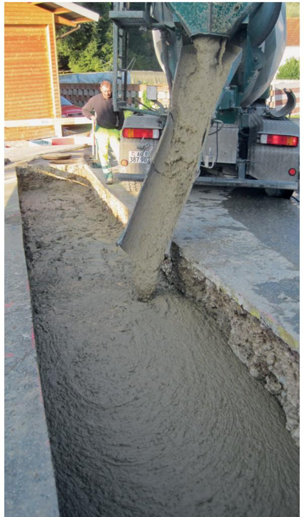
Kanalisationsarbeiten im Flüssigbodenverfahren
