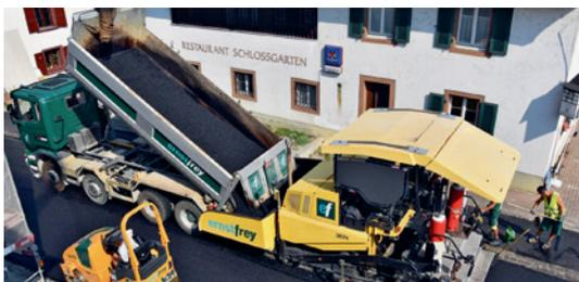
Der Einbaufertiger wird mit Belag beschickt
