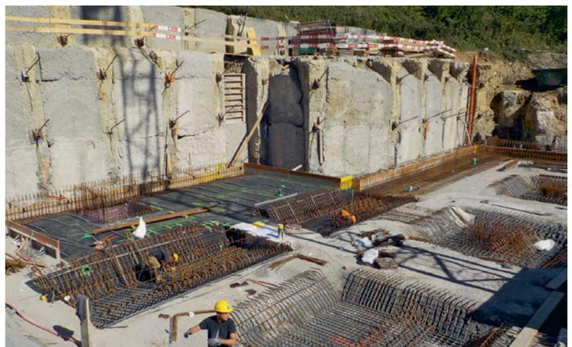
*Nagelwände stützen die Böschung zur Bahnlinie ab*
