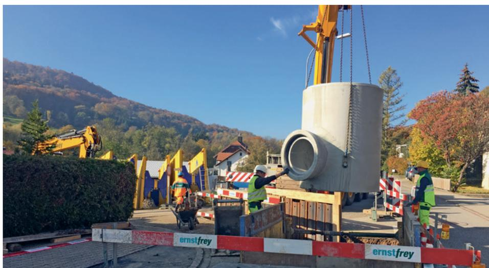
Millimetergenauer Einbau der Schachtelemente
