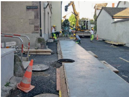
Der neue Gehweg aus einer Betonplatte für Fussgänger
