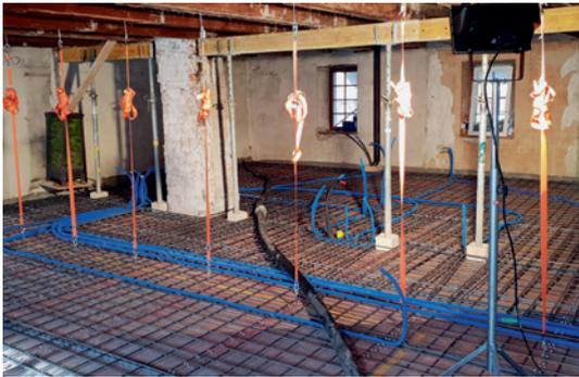
Absicherung der Decke für die Betonarbeiten
