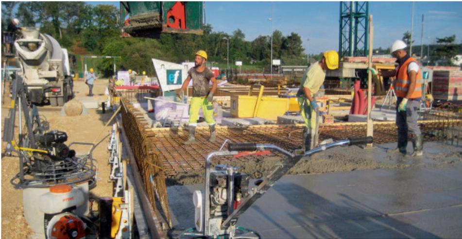
Einbau der Bodenplatte im Monolith-Verfahren
