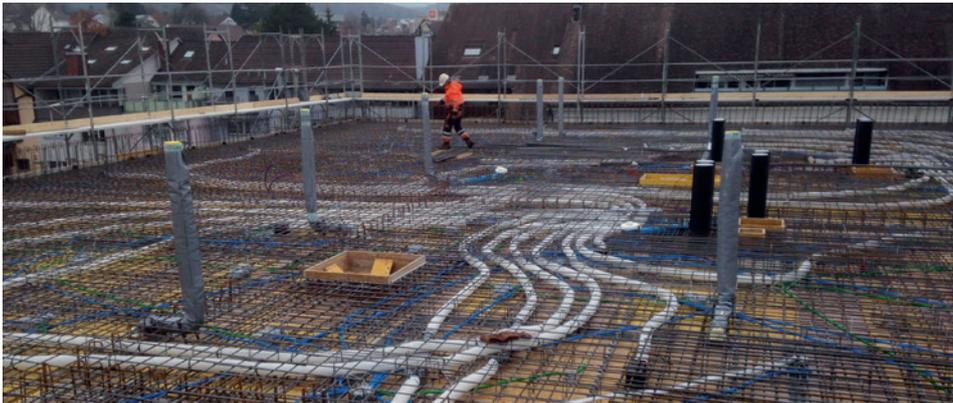
Die Einlegearbeiten werden vor dem Betonieren noch abgeschlossen
