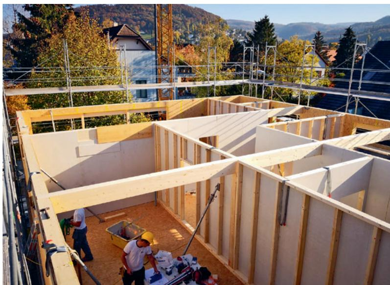
Einbau der vorgefertigten Holzbaulemente
