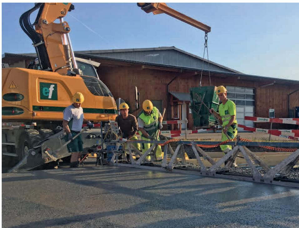
Betonieren der Kreiselfahrbahn mit Vibrobalken
