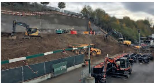
Die Hanganschnitte werden mit einer permanenten Nagelwand gesichert
