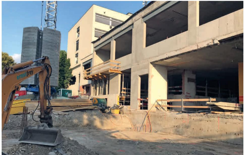
Während der Abbrucharbeiten wurde parallel mit den Stahlbetonarbeiten begonnen
