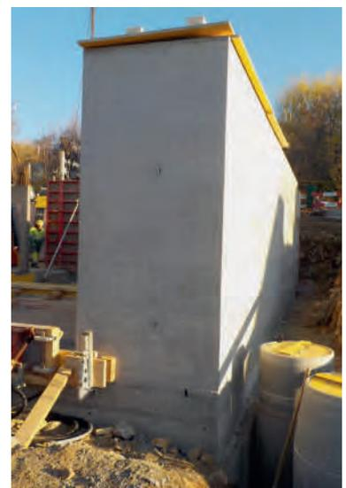
Wände und Decken wurden in Sichtbeton ausgeführt
