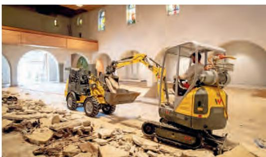
*Akku-Pneulader zum Abtransport des Abbruchmaterials*
