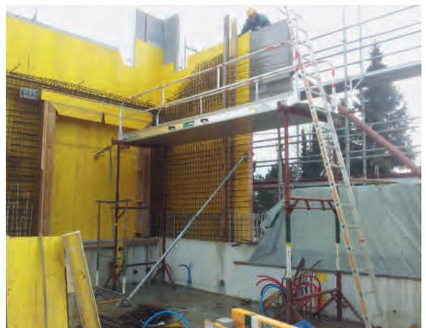
Schalungsarbeiten für die Sichtbetonfassade
