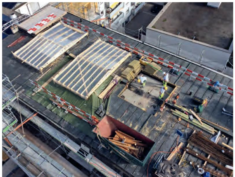
Die Deckenöffnungen werden nach Rohbauende geschlossen
