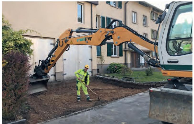
Rückbau einer Betonplatte und Erstellung von Belag in Frenkendorf am Baumgartenweg
