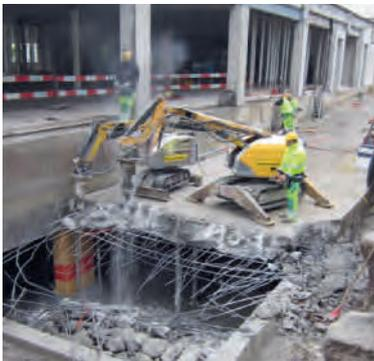
Mittels Abbruchrobotern wurden rund 1000 Tonnen Material abgebrochen
