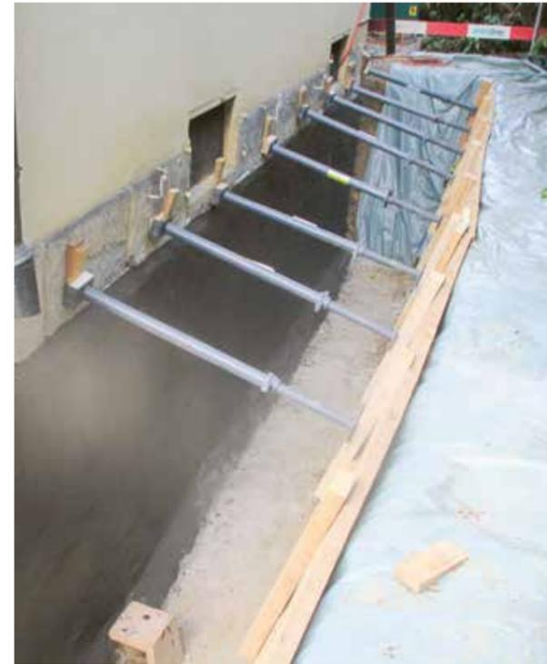
Aufwändige Abdichtungs- und Entwässerungsarbeiten an den Kelleraus-senwänden.
