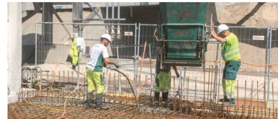
Das Fundament wird aus hauseigenem Beton gegossen.
