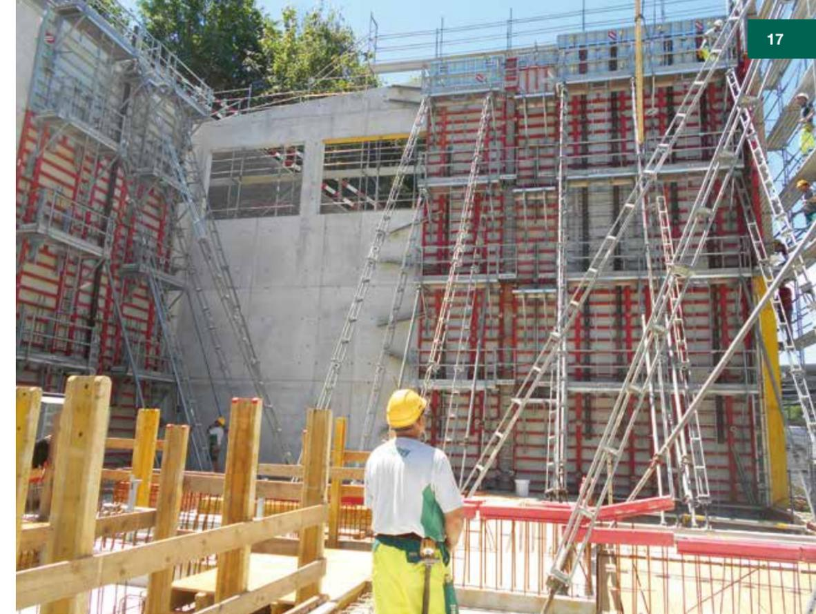
Die 14m hohen Wände wurden in einem Guss betonierte.
