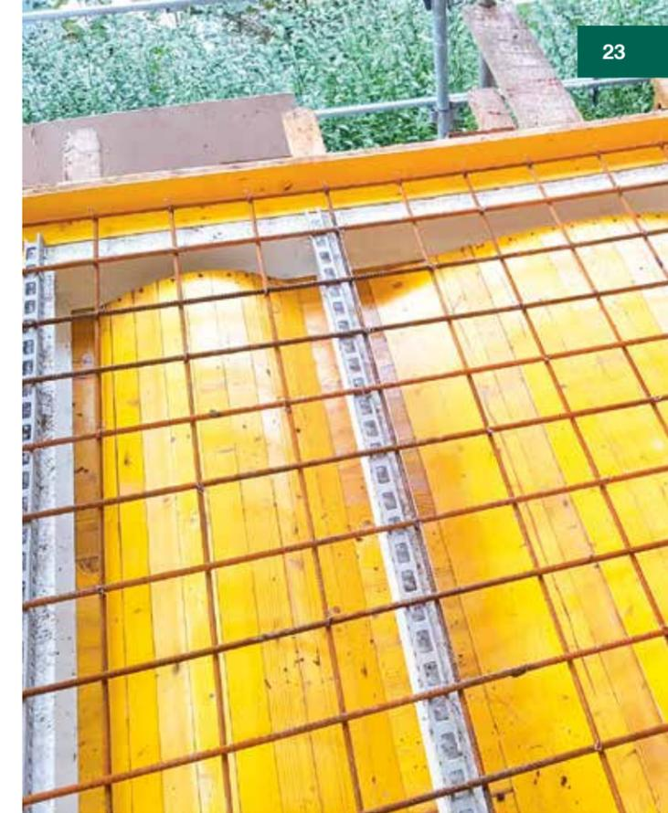
Anbau in Stahlbetonbauweise.
