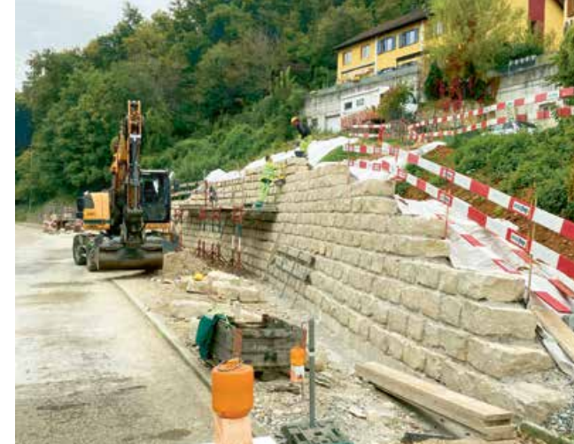
Neue Betonbuchten für den Busverkehr sowie der barrierefreie Ausbau einer Haltestelle gemäss den Vorgaben des Behindertengleichstellungsgesetzes.
