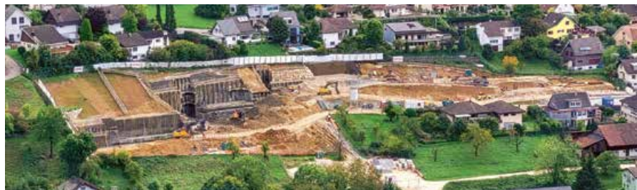
Die steile Böschung der Parzelle und das unwegsame Gelände stellten besondere Anforderungen an die Planung und die Logistik.
