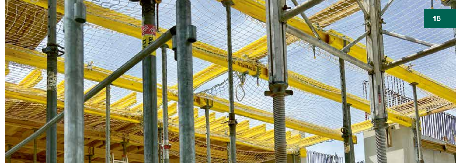
Beim Erstellen der Decken kommen erstmals neue Kollektivschutznetze zum Einsatz und sichern die Handwerker optimal gegen Absturz.
