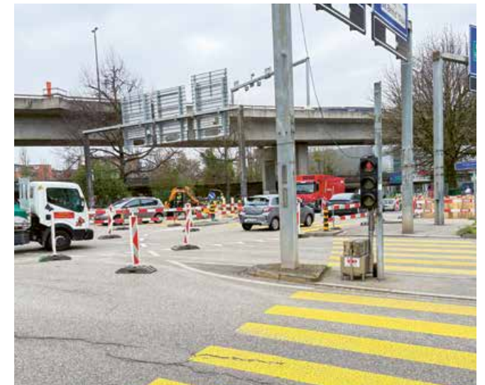
Der Bauablauf erfolgt in drei Bauabschnitten, wobei die Fertigstellung für Juni 2026 vorgesehen ist.
