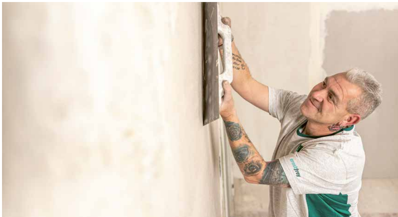
Die Sanierungsarbeiten erfolgen unter beengten Platzverhältnissen und im bewohnten Zustand.
