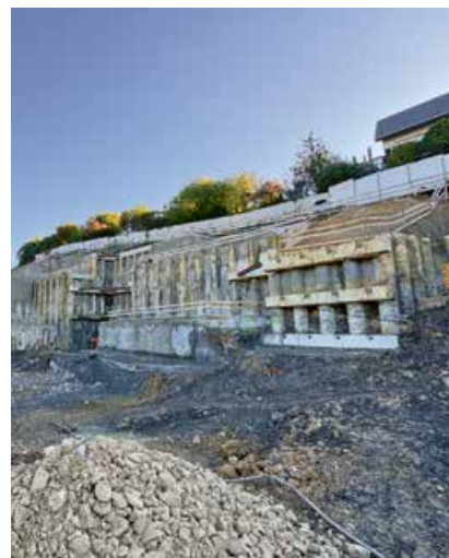
Nach der Erstellung der Bohrpfähle beginnt der Baugrubenaushub in Etappen, parallel erfolgen Nagelwand- und Gunitierarbeiten sowie die Integration von Kopfriegeln und Betonlongarinen zur Baugrubensicherung.
