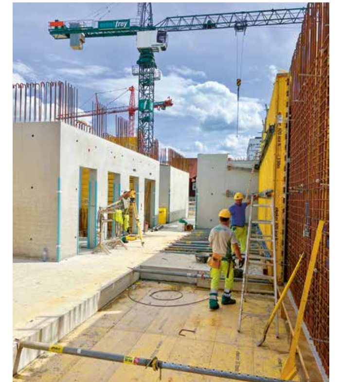
Der Kernbereich wird mit einer speziellen, glatten und grossflächigen X-Face Doka-Schalttafelschalung erstellt.
