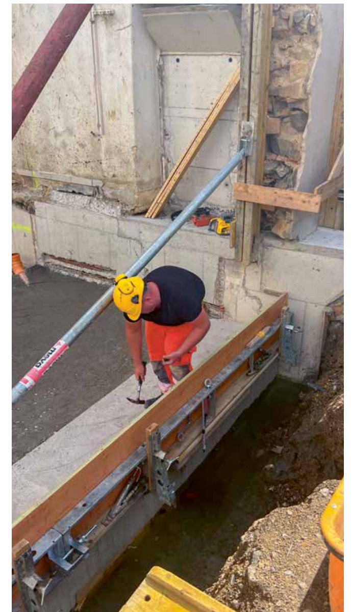
Die Schalungen müssen exakt eingeteilt und die nötigen Anker bereits bei der Bodenplatte platziert werden.
