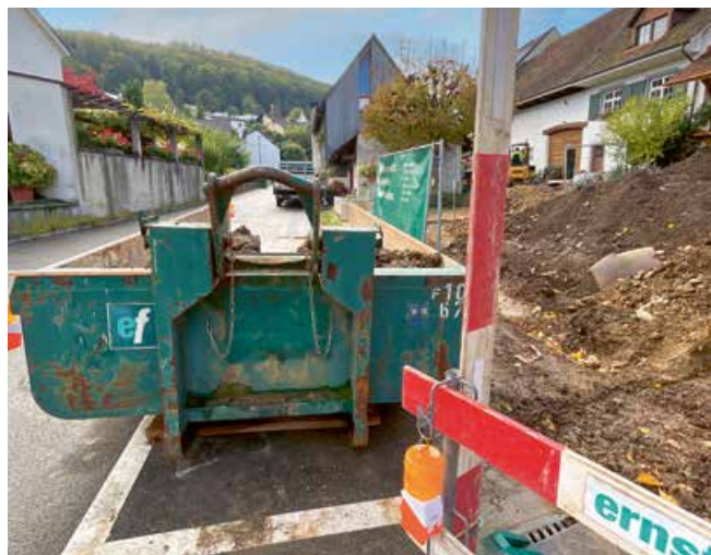
Nach den Abbrucharbeiten sollen möglichst viele Materialien aus dem Bestand wiederverwendet werden.
