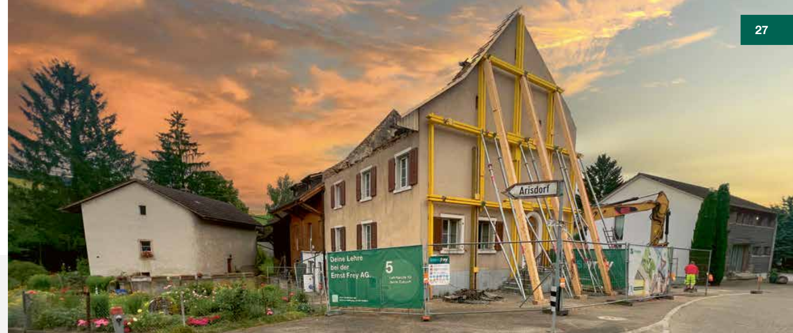
Die Giebelwand wird gesichert, um das prägende Element des Gebäudes zu erhalten und die Abbrucharbeiten am übrigen Altbau gefahrlos zu ermöglichen.
