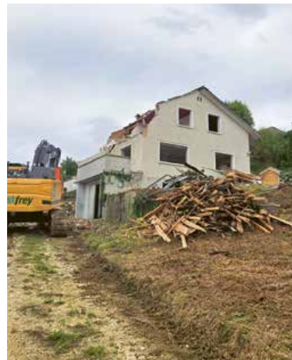
Vor Beginn des Baugrubenaushubs wird ein bestehendes Einfamilienhaus zurückgebaut.
