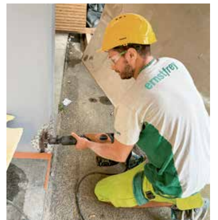
In den Wohnungen werden die Küchen und Nasszellen inkl. Rohrleitungen komplett erneuert.
