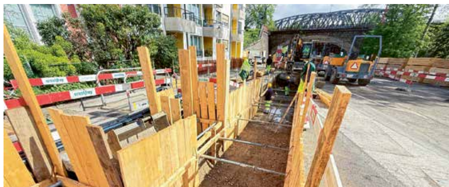
Private Grundstücke und Zufahrten müssen während der Bauarbeiten jederzeit erreichbar bleiben.
