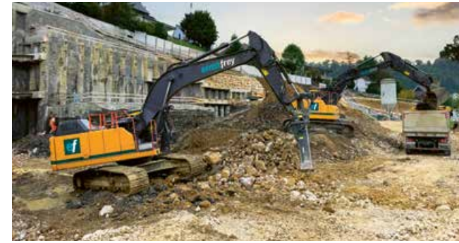
Das Aushubmaterial von rund 35 000 m³ wird ressourcenschonend aufbereitet und als hochwertiges Hinterfüllungsmaterial wiederverwendet.
