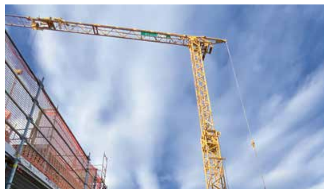
Ein Untendreher wird für die Bedachungsarbeiten im engen Strassenraum des alten Ortskerns aufgestellt.
