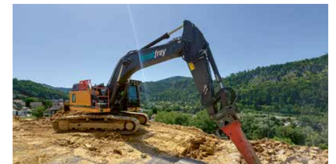
Bereits in geringer Tiefe tritt massiver Fels auf, der nur mit Spitzhammer und Ripperzahn abgetragen werden kann.
