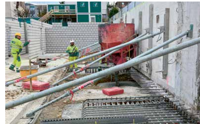
Die bestehenden Untergeschoss-Aussenwände bleiben erhalten, werden abgestützt und im Unterfangungsverfahren verstärkt.
