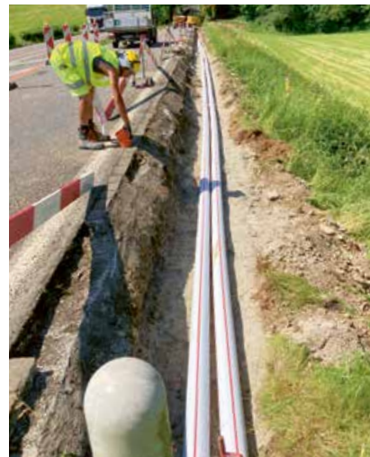
Es werden Werkleitungen verlegt, Randabschlüsse erneuert und Bankettarbeiten durchgeführt.
