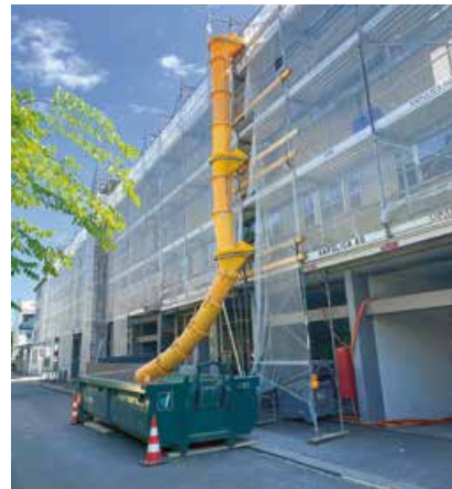
Der Zwischentransport des Abbruchmaterials erfolgt über Schuttröhre direkt in Grossmulden.
