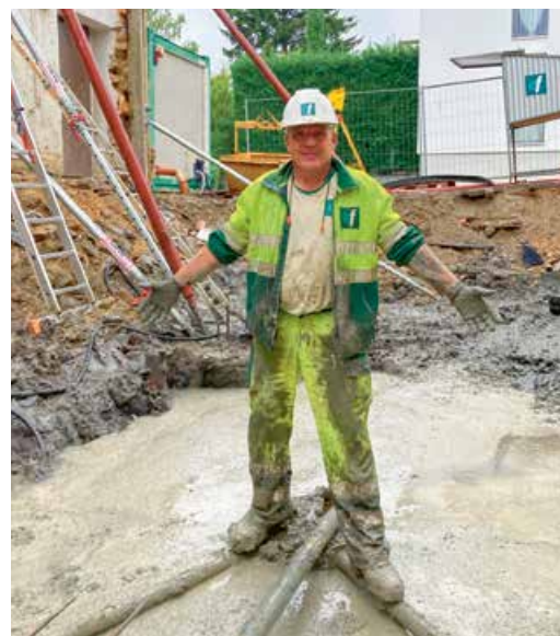
Starke Regenfälle lassen die Baugrube an manchen Tagen bis zu 30 cm unter Wasser stehen.
