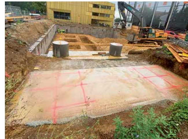
Die Baugrube wird aufgrund enger Platzverhältnisse mit einer nicht verankerten MPS-Wand als vertikaler Abschluss gesichert.
