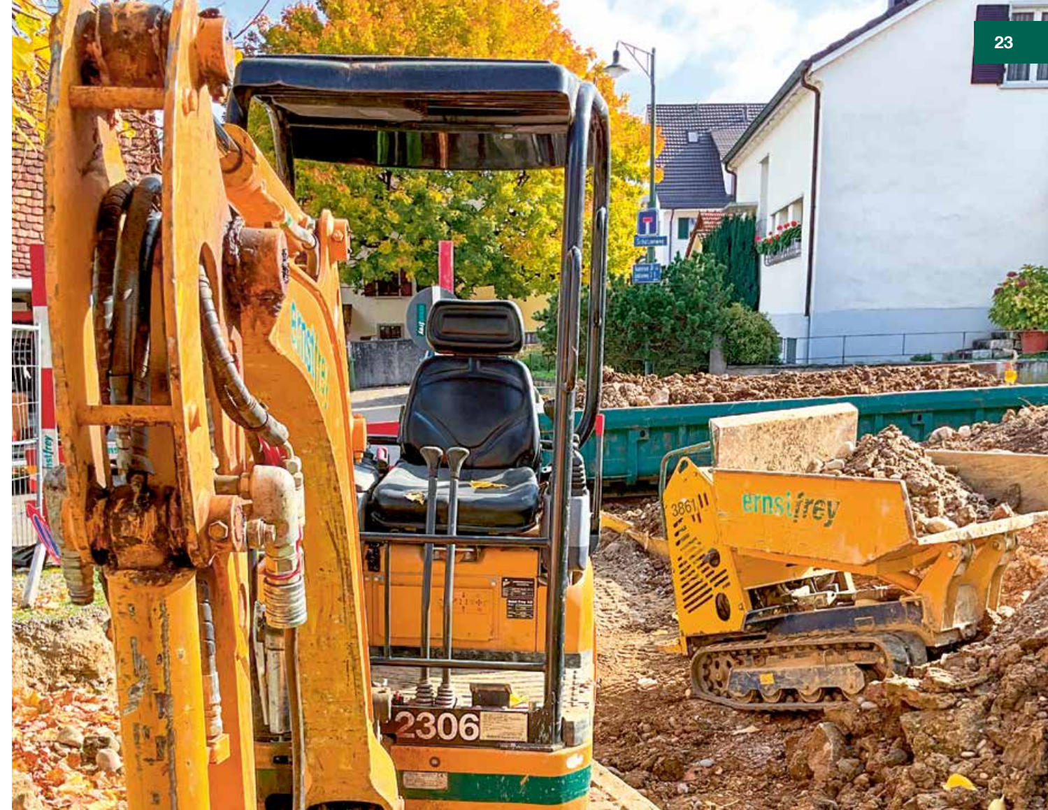
Die Ernst Frey AG gibt gemeinsam mit vielen Beteiligten vollen Einsatz für das Bauvorhaben.
