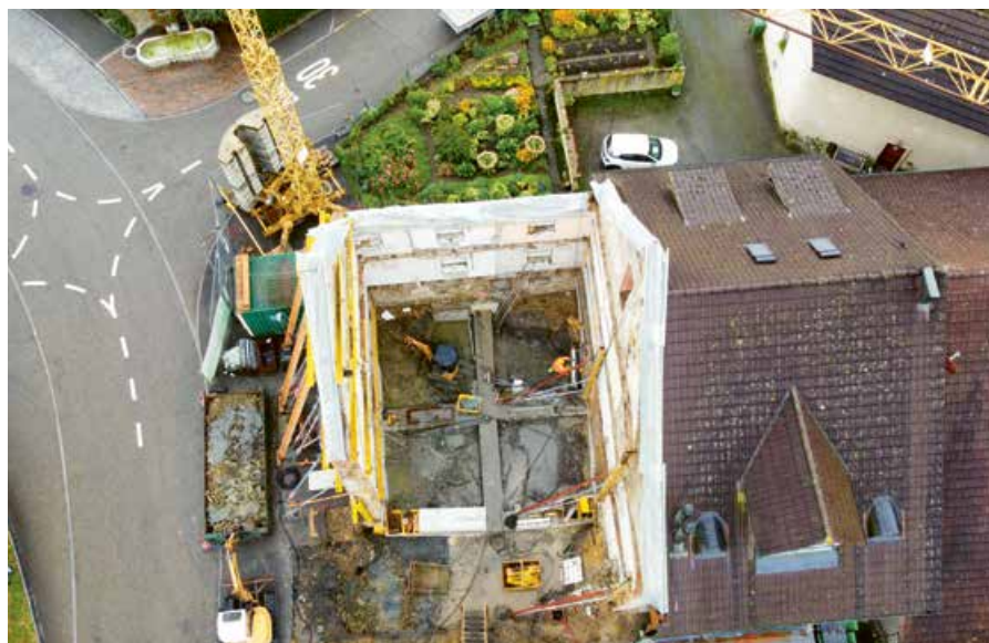
Aussteifungsriegel werden angebracht, die die verbliebene Fassade dauerhaft gegen ein Nachgeben nach innen sichern.
